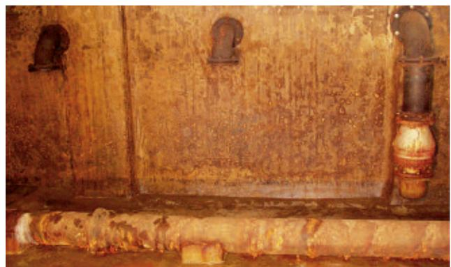
Abb. 2: Vor der Sanierung: Materialzerstörung durch hydrolytische Korrosion an Behälterinnenflächen sowie starker Korrosion an eingebauter Hydraulik
