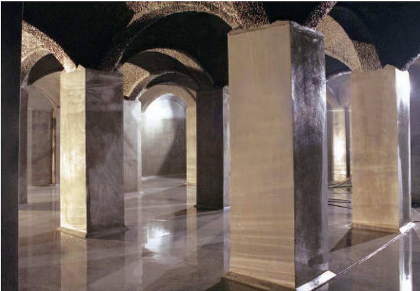
Abb. 3: Nach der Sanierung: Der glatte Belag erleichtert die routinemäßige Zustandskontrolle und Reinigung.
