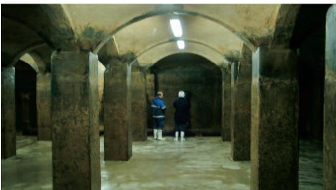
Abb. 1: 16 Säulen stützen das Gewölbe aus dem Jahre 1869. Grundfläche 16 x 16 m, Speichervolumen 640 m<sup>3</sup>. Mit 4,5 bar geht es aus diesem Baudenkmal in die häuslichen Wasserleitungen.
